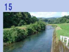
中津川荒瀬橋
