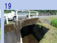
持松道路沿い用水路
