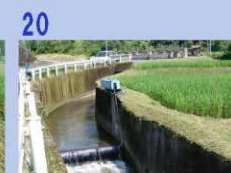
持松道路沿い用水路
